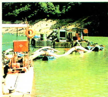
ダム湖底浚渫
